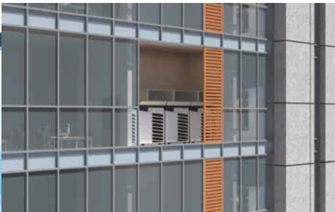
Наружный блок размещается внутри здания, что не нарушает общий вид здания
